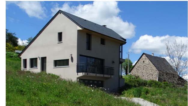
Forme massive, adaptation à la pente, enduit dans les couleurs locales (Le Monteil)
