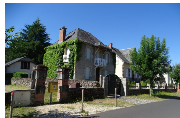
Chemements piétons perméables dans le bourg d'Antignac
