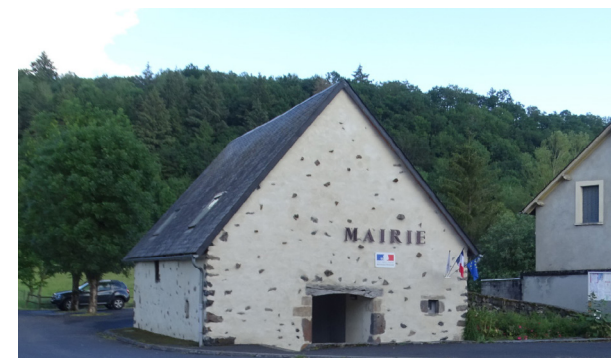
Transformation d'une ancienne grange en mairie (Sauvat)
