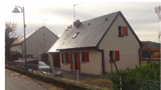
Forme massive, toiture longue couverte d'ardoise en ogive, enduit dans les couleurs locales (Saint-Pierre)
