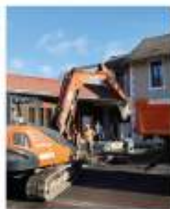
Travaux de terrassement depuis la rue (Rue de l'Éclair)
