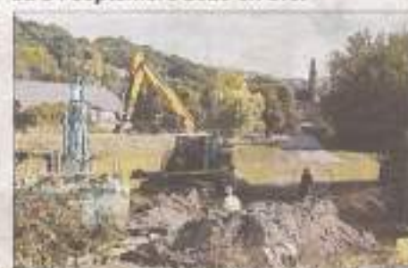
Assainissement à Yverbourg
