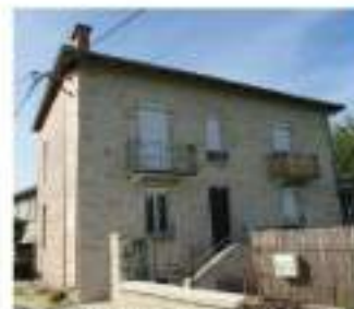
Isolation par l'extérieur des façades nord et ouest : procédé le plus efficace pour réduire les pertes énergétiques, maintien du cachet historique de la façade sud (les coffres de volets roulant devaient être masqués depuis l'extérieur) - Siran
