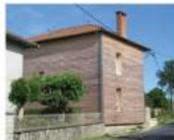
Isolation par l'extérieur des façades nord et ouest : procédé le plus efficace pour réduire les pertes énergétiques, maintien du cachet historique de la façade sud (les coffres de volets roulant devaient être masqués depuis l'extérieur) - Siran
