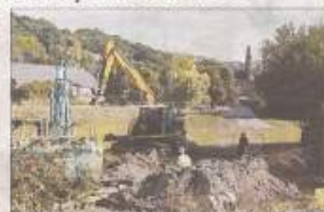
Assainissement à Yverbourg
