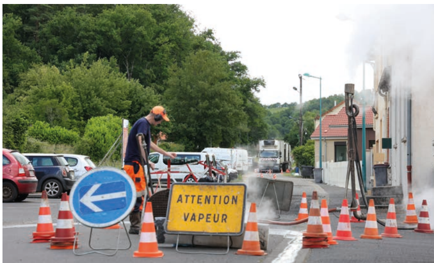
Travaux de réhabilitation des canalisations sans tranchées, réalisés rue Blaise Pascal à Ydes par une entreprise spécialisée.
