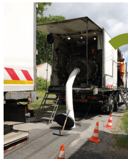
Travaux de réhabilitation des canalisations sans tranchées, réalisés rue Blaise Pascal à Ydes par une entreprise spécialisée.
