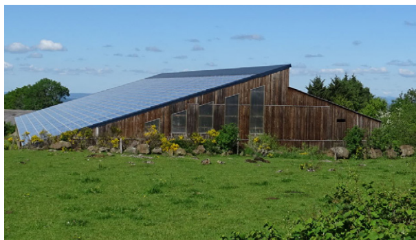
Bâtiment agricole de qualité au Monteil
