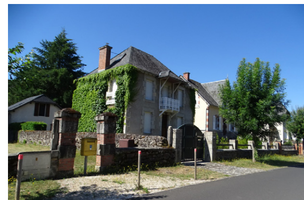
Cheminements piétons perméables dans le bourg d'Antignac
