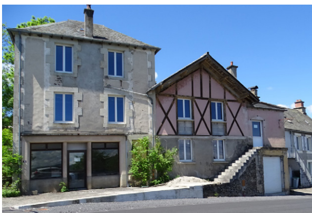
Vitrine commerciale en attente d'une nouvelle activité au Monteil
