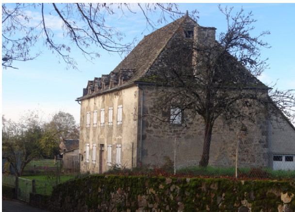
Bâti ancien dont le réinvestissement permettrait la création de plusieurs logements (Veyrières)
