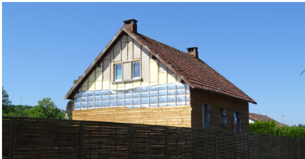
Isolation par l'extérieur d'une maison des années 1950/60 à Champagnac
