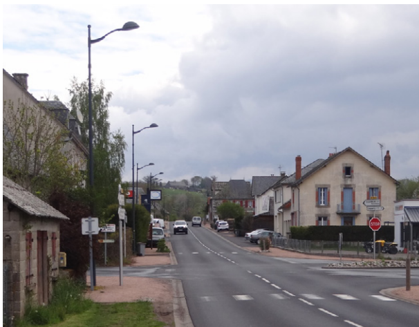
Eclairage public orienté vers le sol à Lanobre
