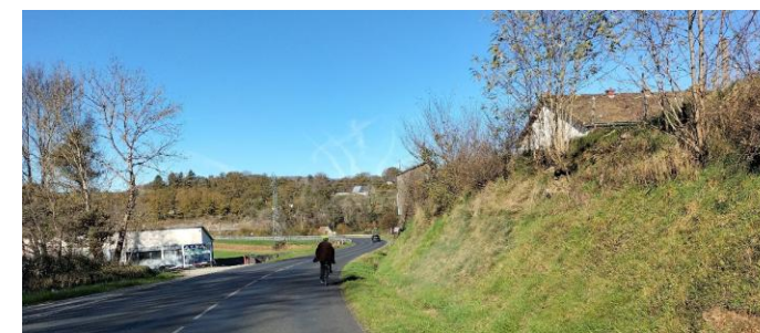
La RD22 en amont de la traversée de la Sumène
